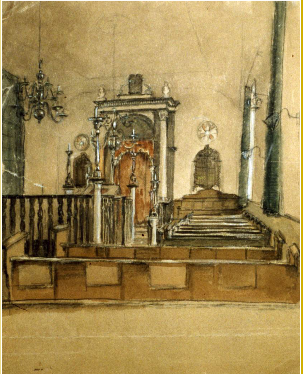
Interieur van de synagoge aan de Koornstraat in Oss. Aquarel van H. de Laat, ca. 1925. Brabant Collectie KUB Tilburg.
